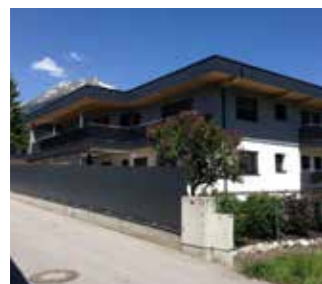
WOHNHAUS R 6460 Imst
