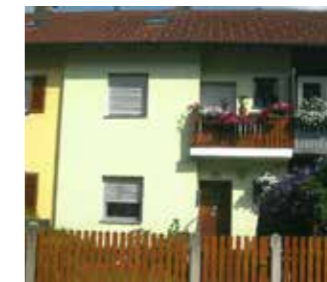
WOHNHAUS G 6130 Schwaz
