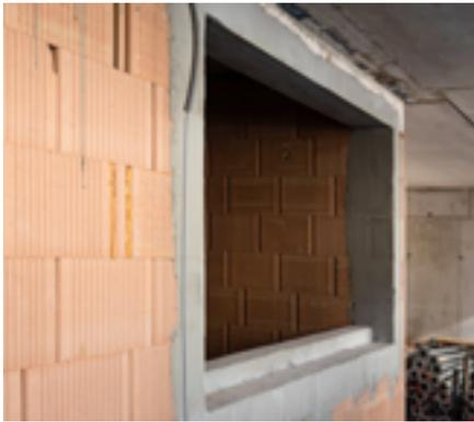
Bei Ziegelmauerwerk wird vor dem Einbau der Fenster ein Glattstrich hergestellt.
