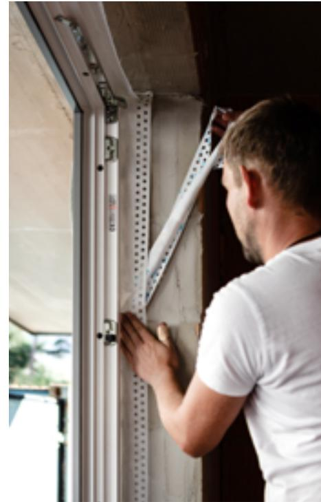
Die Herstellung des luftdichten Anschlusses an der Rauminnenseite und des wind- und schlagregendichten Anschlusses an der Außenseite kann z. B. mit geeigneten Klebebändern umgesetzt werden.
