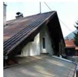
Abb.: Anschlüsse, wie hier von einem Pultdach an die Fassade müssen exakt geplant werden.
