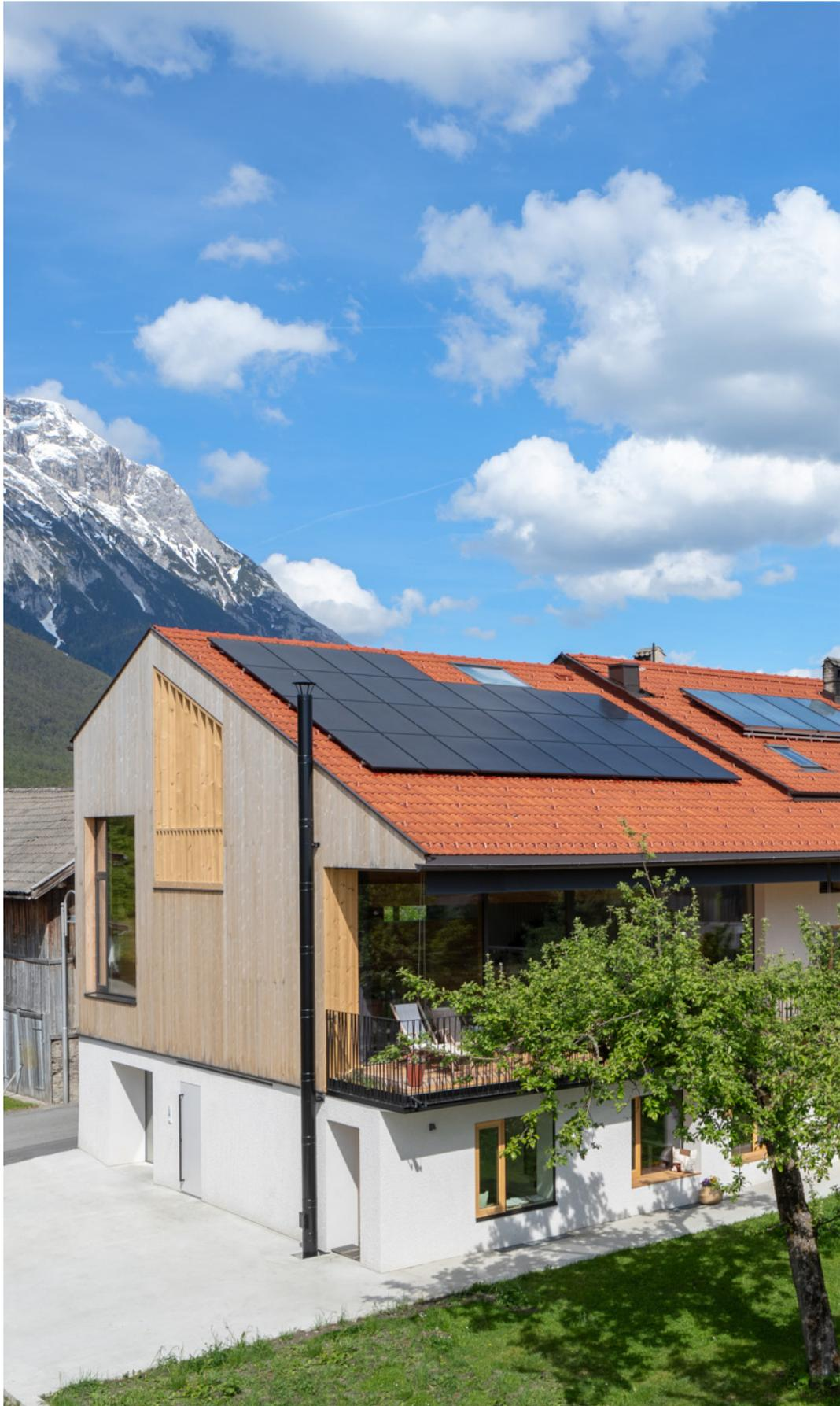
Unter Neigung versteht man den Winkel des Moduls zum Horizont. Bei dachparallelen Anlagen ist der Neigungswinkel des Kollektors abhängig von der Neigung des Daches (ohne Aufständering).
