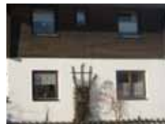
Abb.: Typische Fenster in Wohnhaus aus den 1970ern
