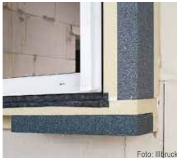
Abb.: vor Ort zusammengefügtter Rahmen
