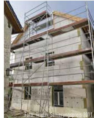
Abb.: Ein gut geplantes und exakt ausgeführtes WDVS bildet die Grundlage für eine lange Haltbarkeit
