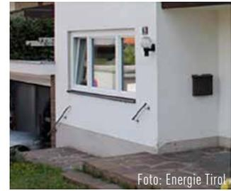
Abb.: Anschlüsse, wie hier im Bereich des Sockels mit Stiegenanschluss oder zum angrenzenden Garagengebäude müssen exakt geplant werden.
