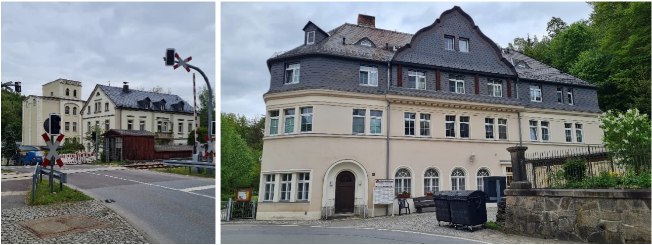
Abb. 17: Versorgte Gebäude in Neumühle / Elster: Wohnhaus der Sternmühle (linke Abbildung, rechtes Gebäude) sowie das Senioren-Wohnheim (rechte Abbildung).
